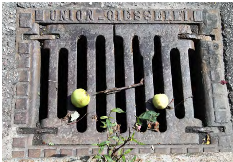
Kanalgitter Union-Gießerei Nähe Hammerteichschleuse
