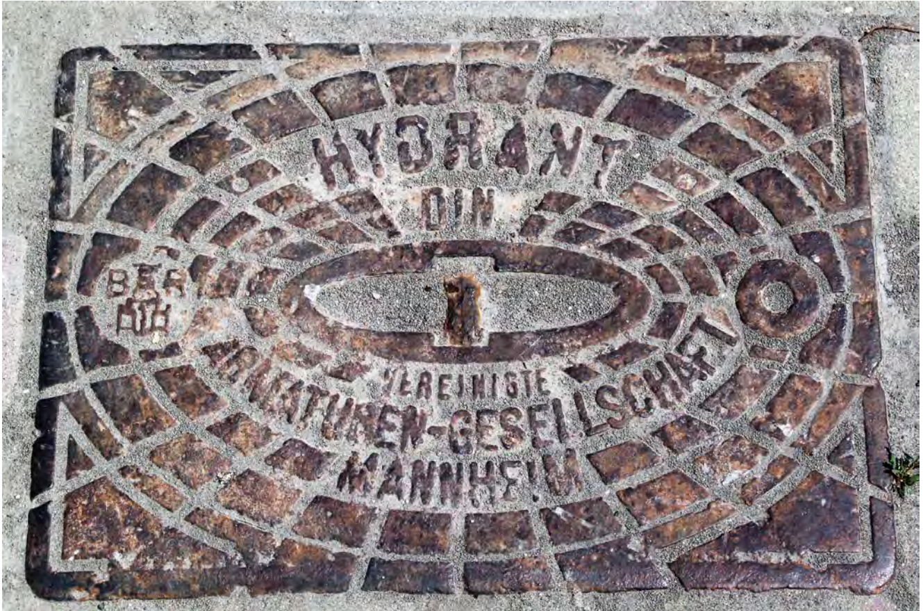
Hydrantendeckel der VAG, Hufen, Höhe Hornstraße
