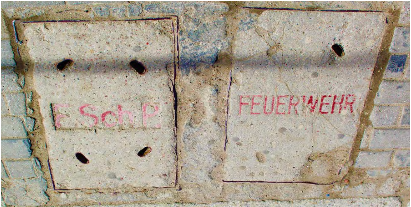
Steindeckel in der Brahmsstraße
