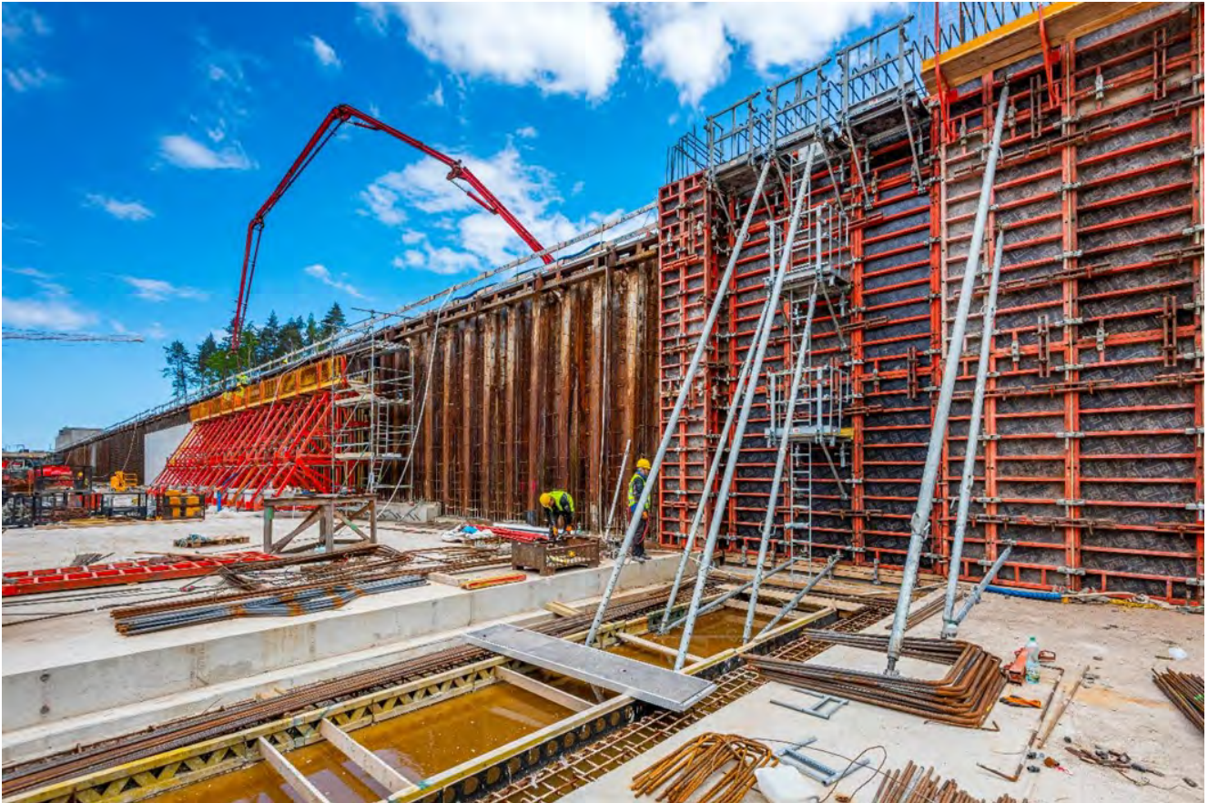
Im Vordergrund rechts PERI Rahmenschalung, weiter hinten links wieder PERI-Vario GT24 Träger-schalung mit Stützbocken SB-A und SB-B (Foto: PERI)
