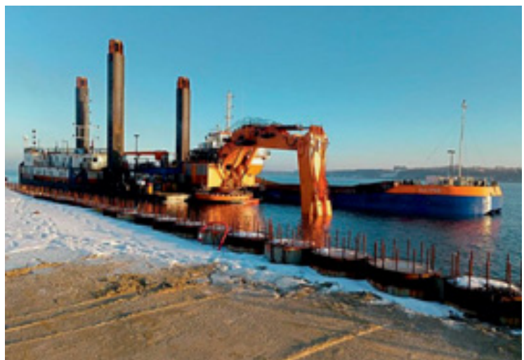
Nach Wiederaufnahme der Arbeiten 2022
