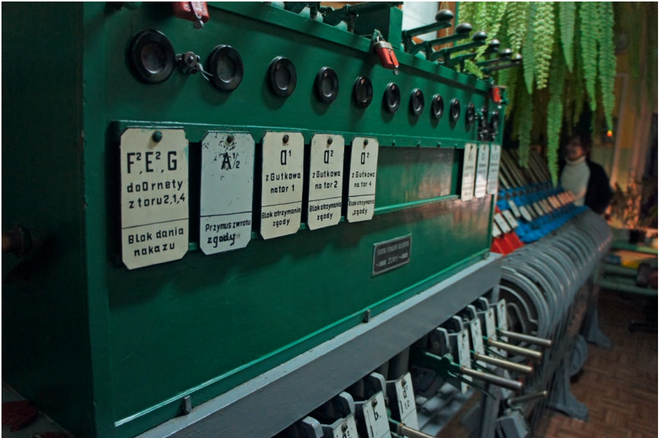
Zum Vergleich: so sah der alte Arbeitsplatz des Fahrdienstleiters in Guttstadt aus – ein mechanisches Stellwerk der Bauart „Einheit“, wie es auf fast allen Bahnhöfen der Strecke vorhanden war...
