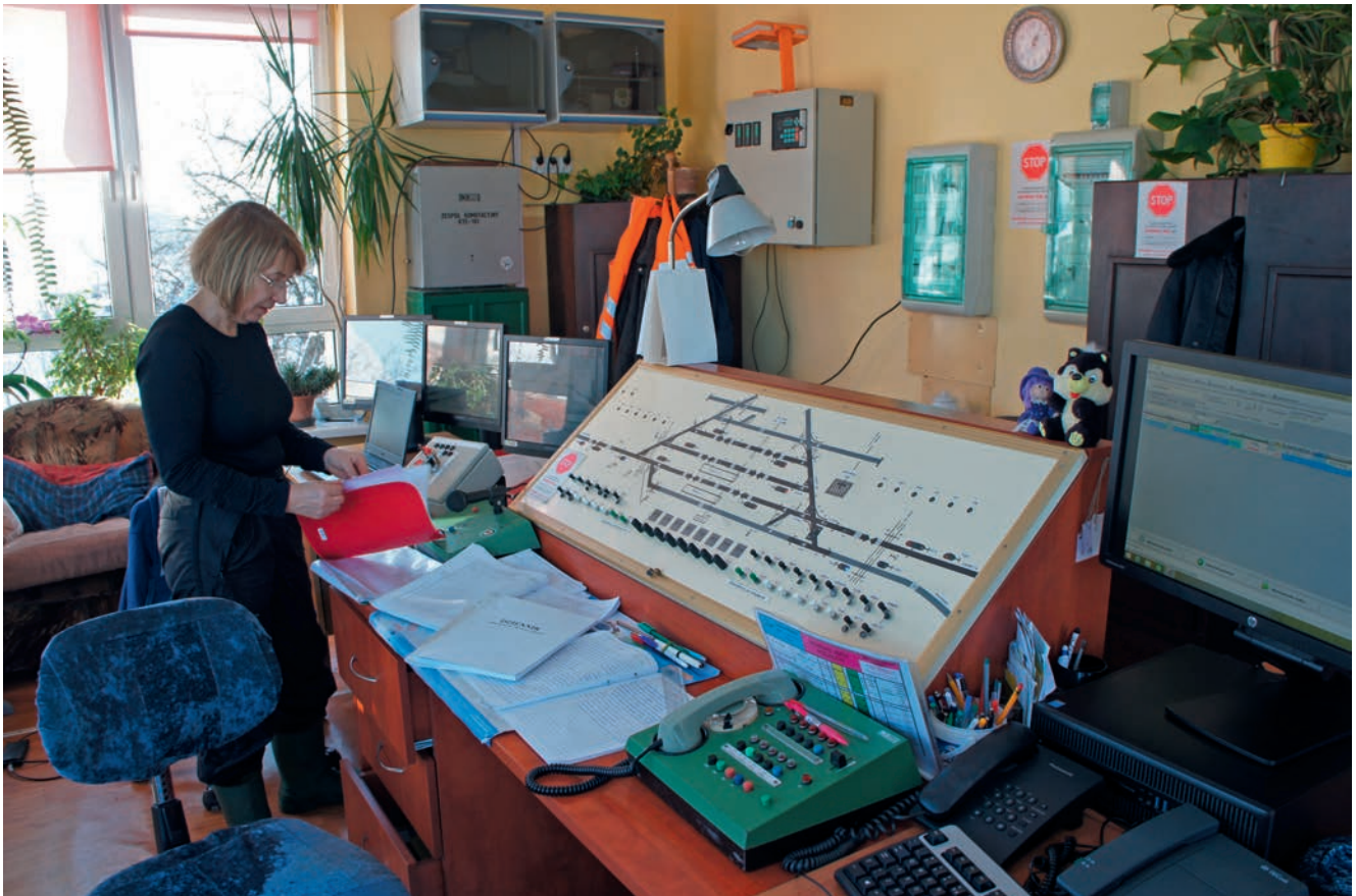
...und so geht es heute zu: ein elektrisches Gleisbildstellwerk hat die Mechanik der Deutschen Reichsbahn abgelöst, Monitore sorgen für die Schrankenüberwachung und die Verbindung mit den Betriebsleitstellen; die Grünpflanzen sind übrigens „vom Alten ins Neue“ mitgekommen! Fahrdienstleiterin Grażyna Juchnowska ist mit der „Buchführung“ beschäftigt
