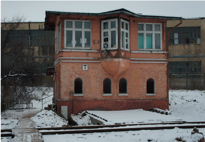
Das Wärterstellwerk in Guttstadt, hier im Dezember 2010...
