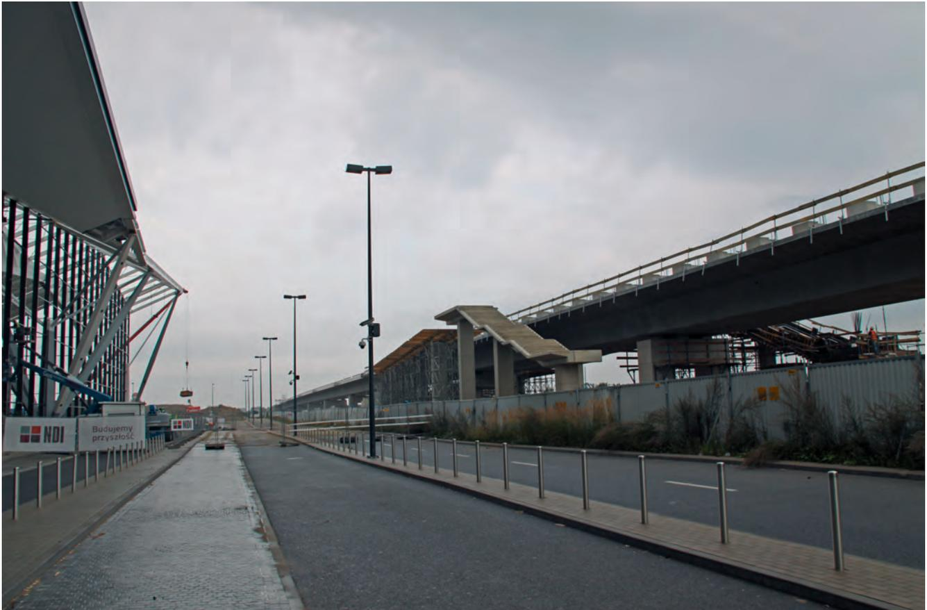
*Die S-Bahn wird in Danzig direkt an der Abflughalle (links im Bild) halten; Mitte/rechts ist der halb fertiggestellte Treppenaufgang und das Hochbauwerk für die Fahrbahn zu erkennen*
